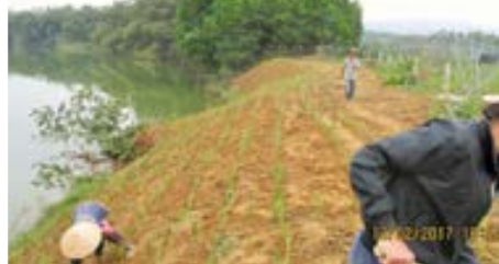
Chuẩn bị và trồng Vetiver _ Slope Preparation and Plantation
